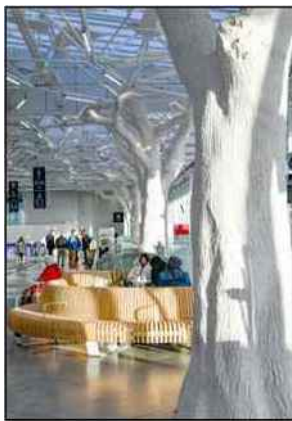
18 piliers en forme d'arbres soutiennent la mezzanine.
